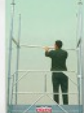
Montaggio del tirante interno
