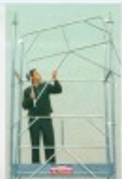
Montaggio della barriera
